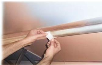
**02** - Retire a calha de acrílico da luminária. Puxe a calha para que se solte a junção.
