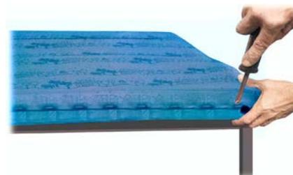
**04** - Coloque o novo revestimento na espuma, passe os arames nos orifícios e fixe-os nas cavidades do encosto com grampos.
