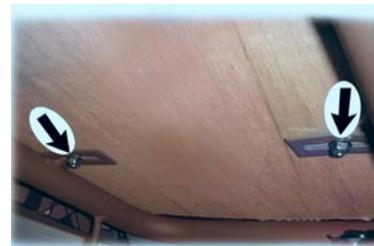
**02** - Remova os grampos de fixação e retire o revestimento danificado.
