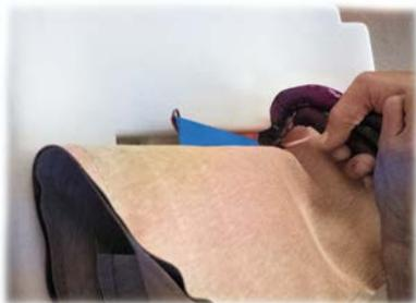
**05** - Revista a espuma por completa, prenda com grampos e parafuse o assento novamente na estrutura.
